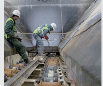
Remplacement des galets usés
