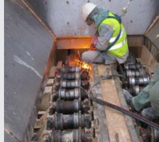
Démontage de la chaîne usée. Vérification de l'état des galets
